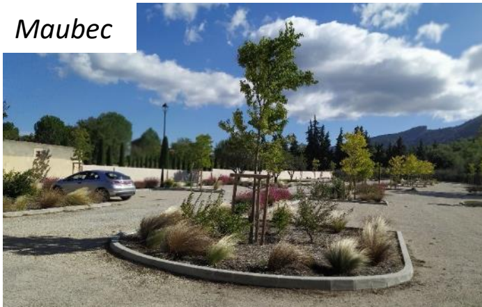
Parking perméable stabilisé
