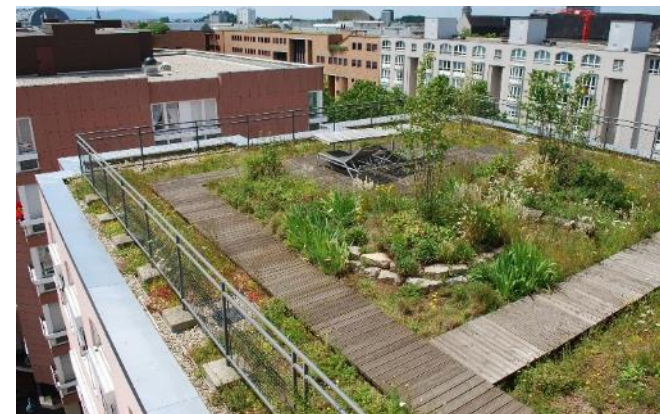
Agence de l'environnement de Karlsruhe avec système de végétalisation riche. Source : Optigrün
